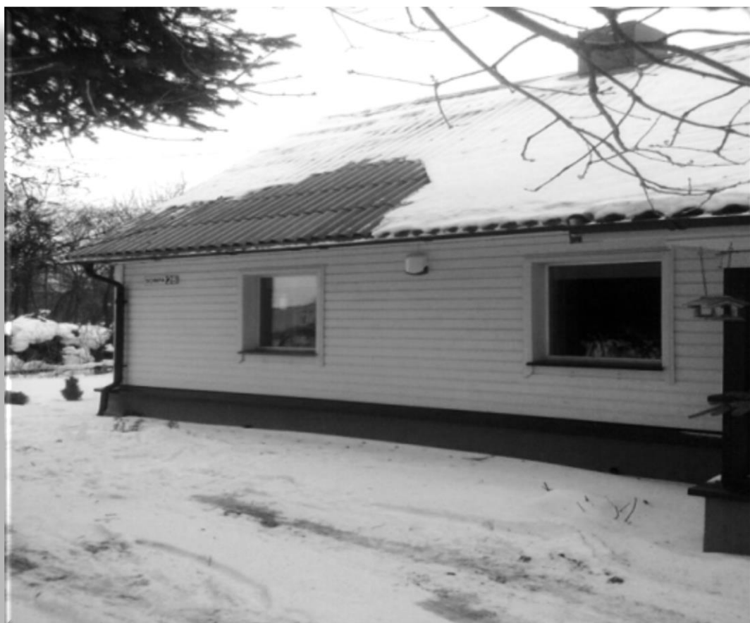
Рис. 19. Вид кровли с обработанной и необработанной поверхностью Силокор «Антилёд». В зоне обработки составом отсутствие образования наледи и снежного покрова
