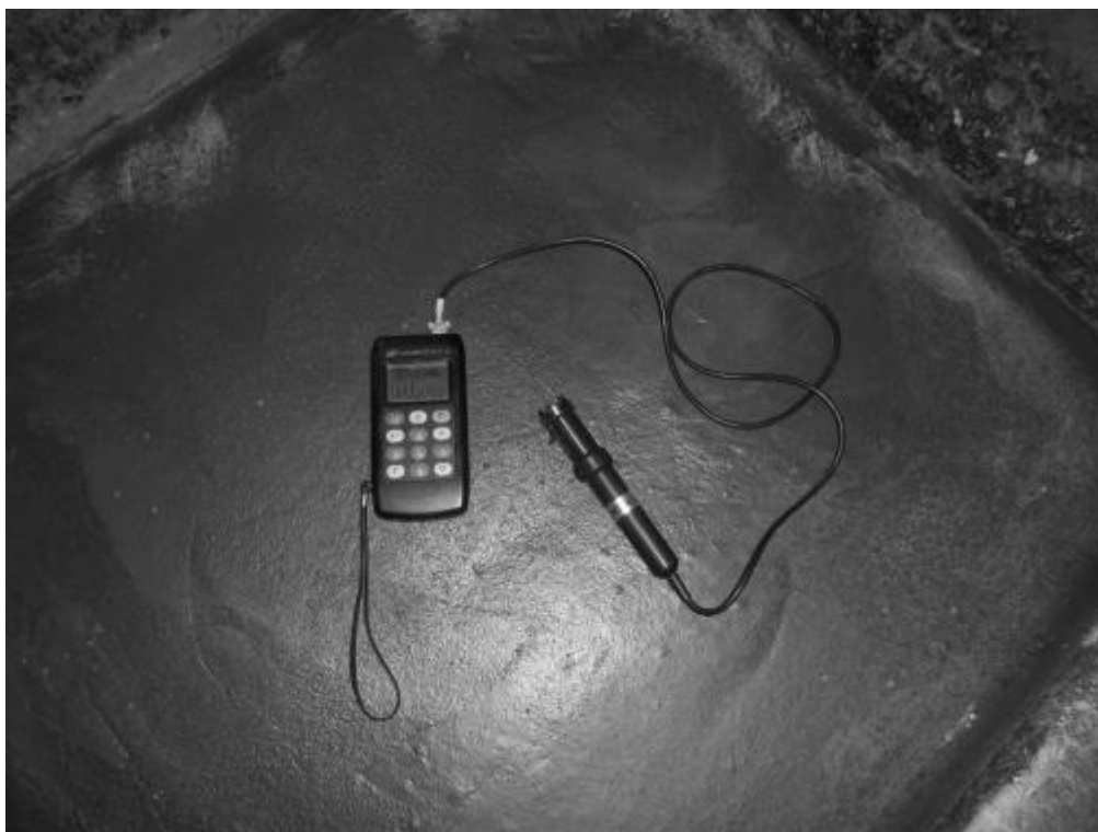
Рис 12. Локальный ремонт ж/б пандуса. Вид покрытия из Ремстрим 50 через 12 часов. Определение прочности на сжатие косвенным методом (показания прибора более 20 МПа)
