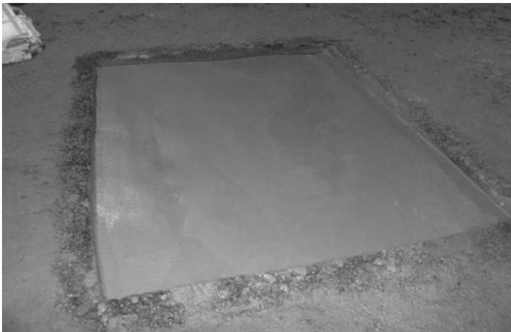
Рис 11. Локальный ремонт ж/б пандуса материалом Ремстрим 50. Вид свежееуложенного покрытия
