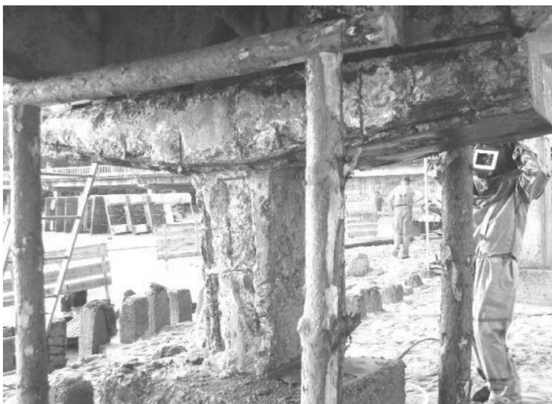
Рис. 8. Разрушение бетона маломассивной опоры с оголением и коррозией арматуры
