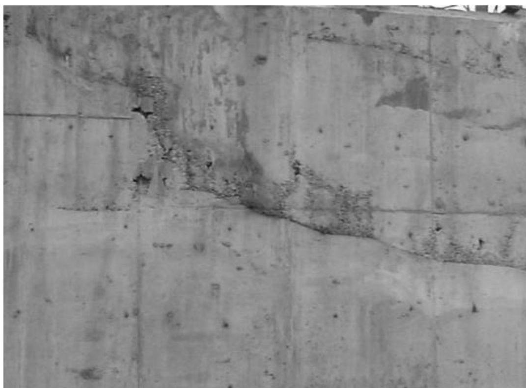
Рис. 3. Щебенистость на поверхности стены и полости, незаполненные бетоном
